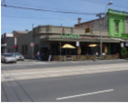
Bridge Rd 406-410.JPG
