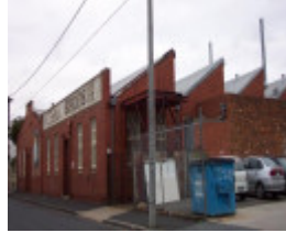
Reid St 36-30 _6164.JPG
