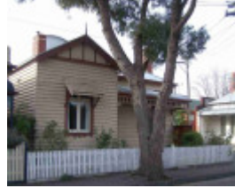
Fitzroy North Tait Street 13 v2.JPG
