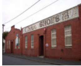
Reid St 36-30 _6166.JPG
