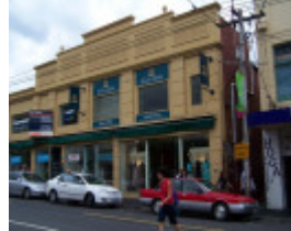
Bridge Rd 173-179 6332.JPG
