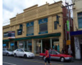
Bridge Rd 173-179 6332.JPG
