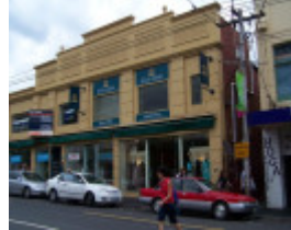
Bridge Rd 173-179 6332.JPG
