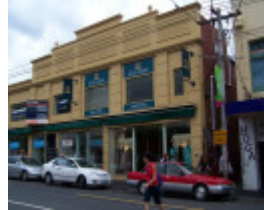
Bridge Rd 173-179 6332.JPG
