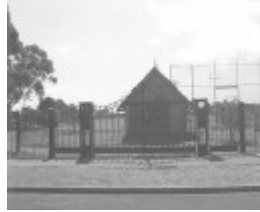
Site 042 - HV McKay Memorial Gates.jpg
