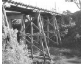
Site 012 - Arundel Road Trestle Bridge.jpg
