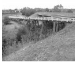
Site 012 - Trestle Bridhge - Arundel Road bridge.jpg
