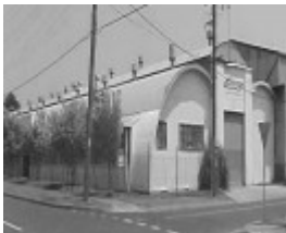
Site 110 - Standard Steel.jpg
