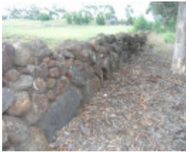
HO017 Derrimut Wall 3.JPG
