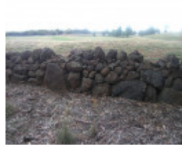
HO017 Derrimut Wall 1.JPG
