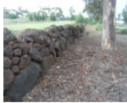
HO017 Derrimut Wall 2.JPG
