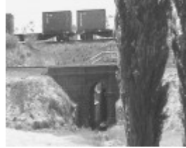
Site 027 - Black Arch Rail bridge (2).jpg
