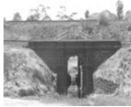
Site 027 - Black Arch Rail bridge.jpg
