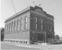
Site 003 - Albion VR, DC sub station.jpg
