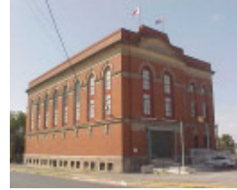
Site 003 - Albion VR, DC sub station (2).jpg
