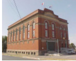
Site 003 - Albion VR, DC sub station (2).jpg
