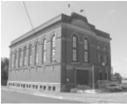
Site 003 - Albion VR, DC sub station.jpg
