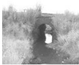
Site 028 - Railway culvet.jpg
