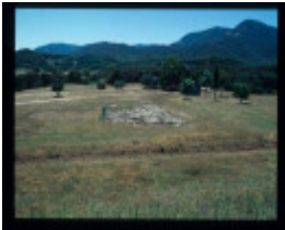
LAKE BUFFALO SPILLWAY
