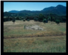
LAKE BUFFALO SPILLWAY
