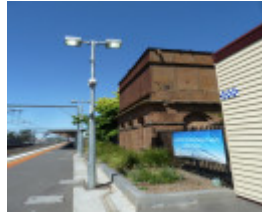
H1673 WATER TOWER LHA 2015 1.JPG
