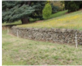
Ha Ha retaining wall.jpg
