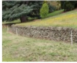
Ha Ha retaining wall.jpg
