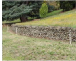
Ha Ha retaining wall.jpg
