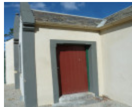
H1947 OVERNEWTON GATEHOUSE LHA 2015 3.JPG
