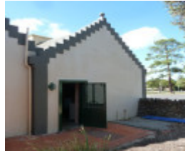
H1947 OVERNEWTON GATEHOUSE LHA 2015 1.JPG
