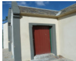
H1947 OVERNEWTON GATEHOUSE LHA 2015 3.JPG
