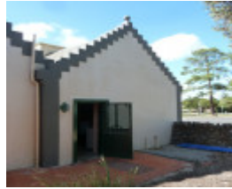
H1947 OVERNEWTON GATEHOUSE LHA 2015 1.JPG
