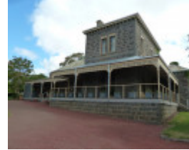
H0281 TARNDWARNCOORT HOMESTEAD LHA 2015 1.JPG
