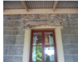
H0281 TARNDWARNCOORT HOMESTEAD LHA 2015 4.JPG
