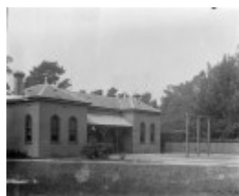
Cottage hospital (1024x757).jpg
