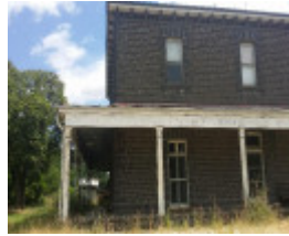
Ingleby Southern Elevation 2016.jpg
