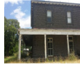
Ingleby Southern Elevation 2016.jpg
