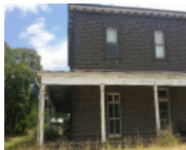
Ingleby Southern Elevation 2016.jpg
