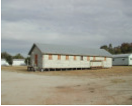
Storehouse (Blanket Store)
