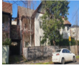
3-2 Como Avenue South Yarra
