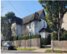
1-2 Como Avenue South Yarra
