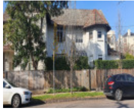
2-2 Como Avenue South Yarra
