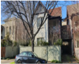
4-2 Como Avenue South Yarra
