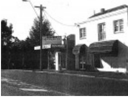
Long Gully Ironbark Comm Res Precinct 5.1 Ironbark Township.jpg
