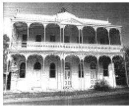
Long Gully Ironbark Comm Res Precinct 5 Gold Mines Hotel.jpg
