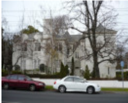
Gradsden Hall Flats
