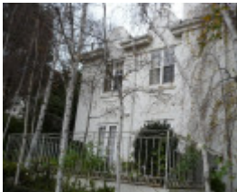
Gradsden Hall Flats
