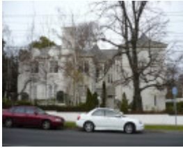
Gradsden Hall Flats
