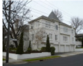
Gradsden Hall Flats
