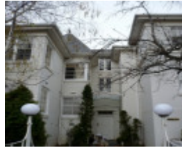
Gradsden Hall Flats
