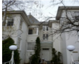
Gradsden Hall Flats
