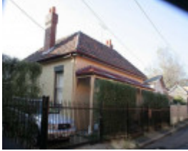
RICHMOND SHAMROCK STREET 1.jpg
