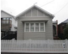
IMG_1364 6 Park Ave.JPG
