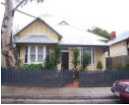
RICHMOND BENSON STREET 1.jpg
