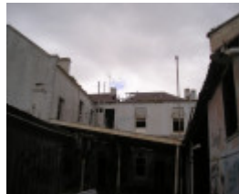
Ritz Flats - Photo 6
