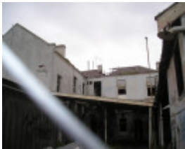
Ritz Flats - Photo 4
