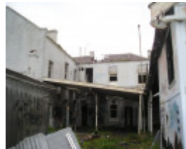
Ritz Flats - Photo 5
