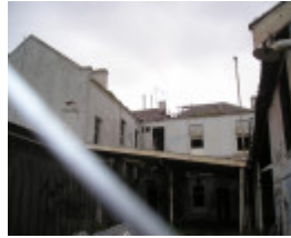
Ritz Flats - Photo 3
