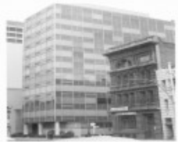
B7666 Hume House (2).jpg
