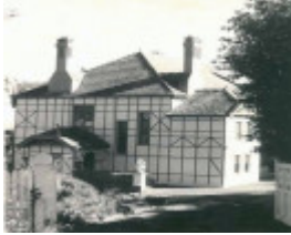
B3454 Derriweit Entrance Gates
