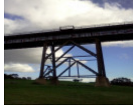
B5206 Moonee Ponds Creek viaduct
