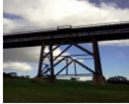
B5206 Moonee Ponds Creek viaduct
