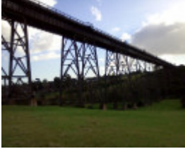
B5206 Moonee Ponds Creek viaduct
