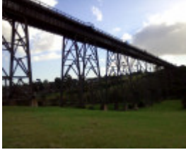
B5206 Moonee Ponds Creek viaduct
