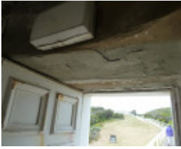
H1222 CAPE OTWAY LIGHTSTATION LHA 2015 2.JPG
