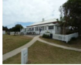
H1222 CAPE OTWAY LIGHTSTATION LHA 2015 6.JPG
