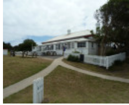
H1222 CAPE OTWAY LIGHTSTATION LHA 2015 6.JPG
