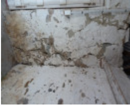
H1222 CAPE OTWAY LIGHTSTATION LHA 2015 5.JPG
