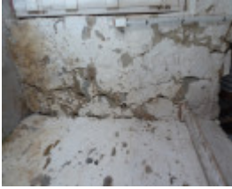
H1222 CAPE OTWAY LIGHTSTATION LHA 2015 5.JPG
