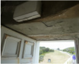
H1222 CAPE OTWAY LIGHTSTATION LHA 2015 2.JPG
