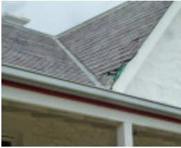
H1222 CAPE OTWAY LIGHTSTATION LHA 2015 8.JPG
