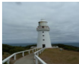
H1222 CAPE OTWAY LIGHTSTATION LHA 2015 1.JPG
