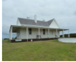
H1222 CAPE OTWAY LIGHTSTATION LHA 2015 7.JPG
