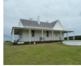
H1222 CAPE OTWAY LIGHTSTATION LHA 2015 7.JPG
