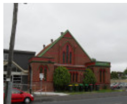
Buckley St 124.JPG
