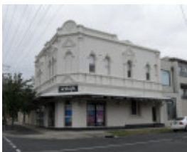
Buckley St 187.JPG
