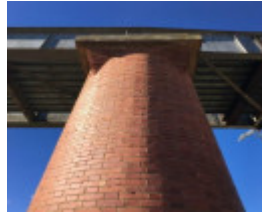
2018 top of 1896 pier.jpg
