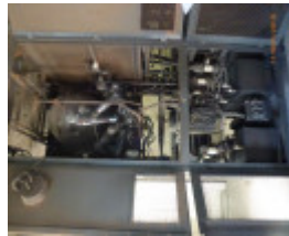
Mercury arc rectifier
