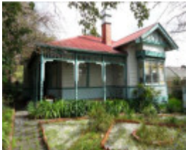
Klota - 342 Canterbury Road.JPG
