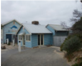
21952 Boot room new kiosk
