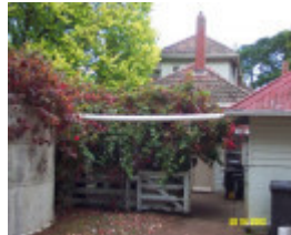
23230 Dunroe Byaduk North garage 0052
