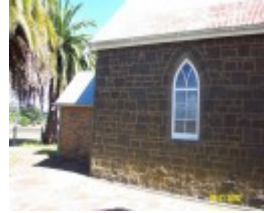
23270 Uniting Ch Byaduk side elevation 0373
