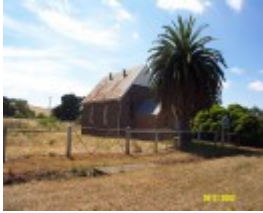
23270 Uniting Ch Byaduk 0375
