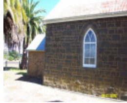
23270 Uniting Ch Byaduk side elevation 0373
