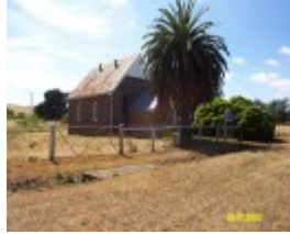
23270 Uniting Ch Byaduk 0374
