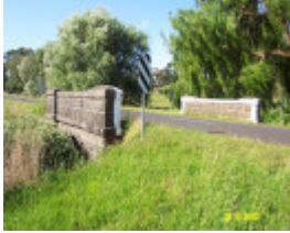
23271 Scott s Creek Bridge Byaduk 2211
