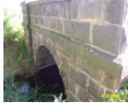
23271 Scott s Creek Bridge Byaduk 2213
