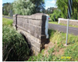
23271 Scott s Creek Bridge Byaduk 2212
