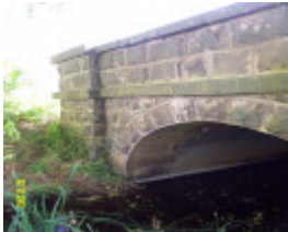
23271 Scott s Creek Bridge Byaduk 2214
