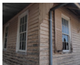
H1570 KOONDROOK TRAM COMPLEX LHA 2015 4.JPG
