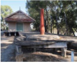
H1570 KOONDROOK TRAM COMPLEX LHA 2015 6.JPG
