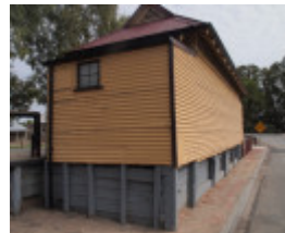
H1570 KOONDROOK TRAM COMPLEX LHA 2015 2.JPG
