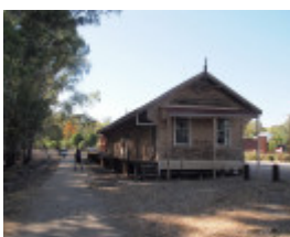
H1570 KOONDROOK TRAM COMPLEX LHA 2015 3.JPG
