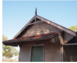
H1570 KOONDROOK TRAM COMPLEX LHA 2015 7.JPG
