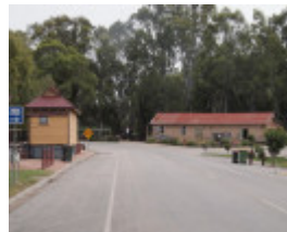
H1570 KOONDROOK TRAM COMPLEX LHA 2015 1.JPG
