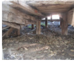
H1570 KOONDROOK TRAM COMPLEX LHA 2015 8.JPG
