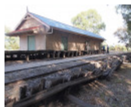
H1570 KOONDROOK TRAM COMPLEX LHA 2015 5.JPG
