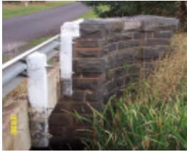
23629 Lyne Creek Bridge Nth Byaduk 0637
