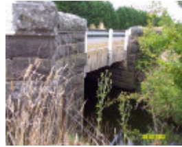
23629 Lyne Creek Bridge Nth Byaduk 0636
