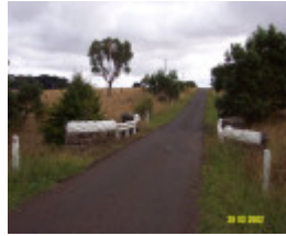
23629 Lyne Creek Bridge Nth Byaduk 0635
