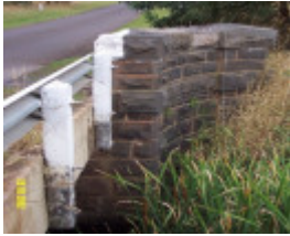
23629 Lyne Creek Bridge Nth Byaduk 0637
