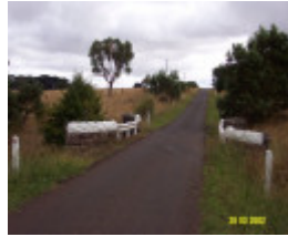
23629 Lyne Creek Bridge Nth Byaduk 0635
