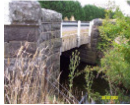
23629 Lyne Creek Bridge Nth Byaduk 0636
