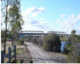
HO146(1) - Angliss Stock Bridge 1.jpg
