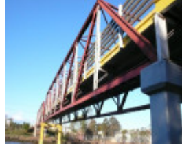
HO146(2) - Angliss Stock Bridge 2.jpg
