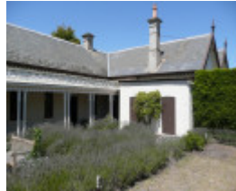
BARWON GRANGE SOHE 2008
