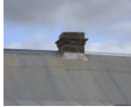
206170_Redesdale_Kyneton Redesdale Road_2406 img14
