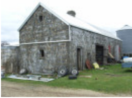
206170_Redesdale_Kyneton Redesdale Road_2406 img01
