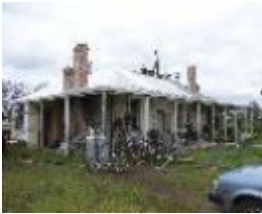
206170_Redesdale_Kyneton Redesdale Road_2406 img18
