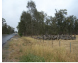
DANNS BRIDGE SOHE 2008
