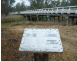
DANNS BRIDGE SOHE 2008
