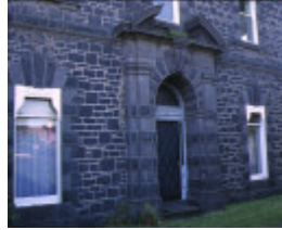
d'estaville kew detail of stone entrance
