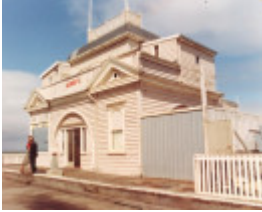
B5471 Kiosk St Kilda Pier
