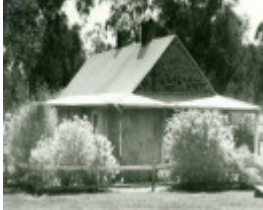
B1644 Schwerkolt's Cottage
